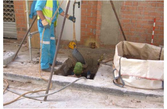
FOTO 2. Treballs realitzats a l'indret de la intervenció
